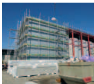
Aperçu des travaux depuis l'A1.
