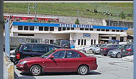
Le garage avant la démolition en avril 2015.
